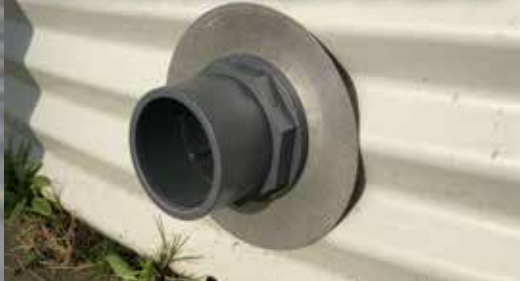
Raccordement à la paroi du réservoir
